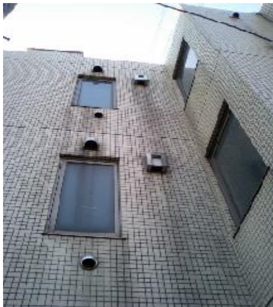
タイル外壁 汚ダレ除去・除菌洗浄
